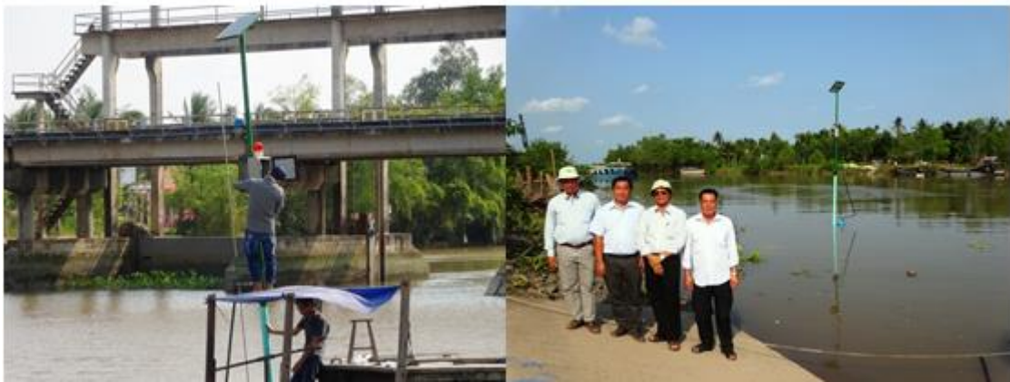
Hình 5. Ảnh chụp Hệ thống cảnh báo xâm nhập mặn tự động dạng cố định của INT được lắp đặt ở xã Trung Thành Đông, huyện Vũng Liêm, tỉnh Vĩnh Long.
