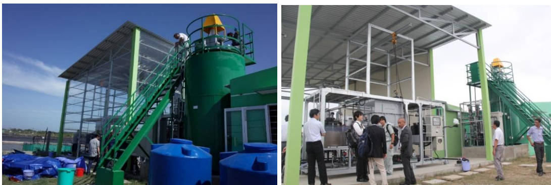
Hình 9. Ảnh chụp PTN trình diễn Dự án (Demo-site) tại Công ty Hoàng Vũ, Bình Đại, Bến Tre.
